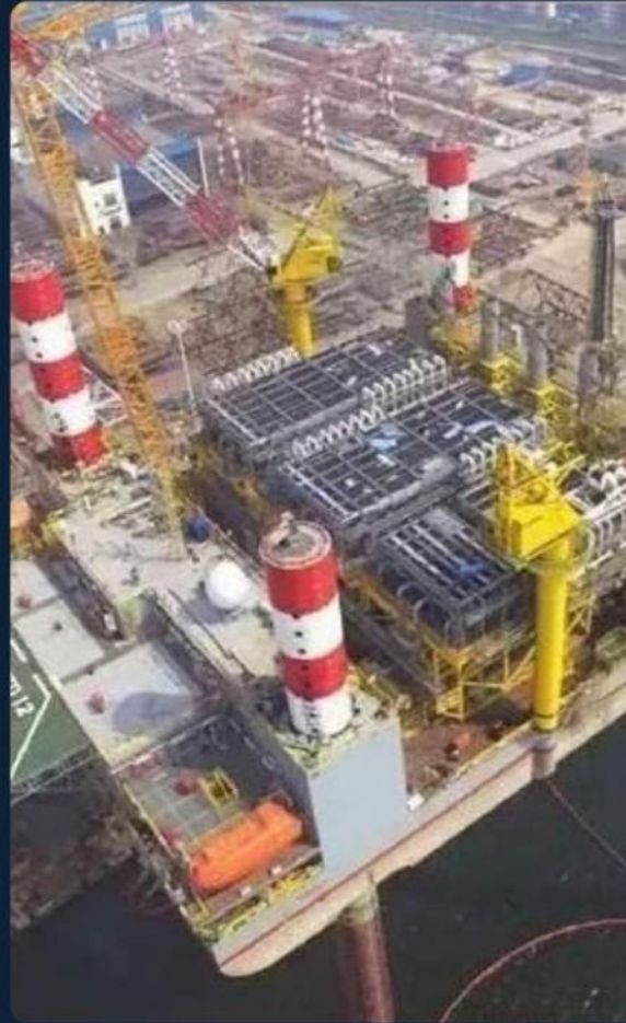
Construcción en astillero
